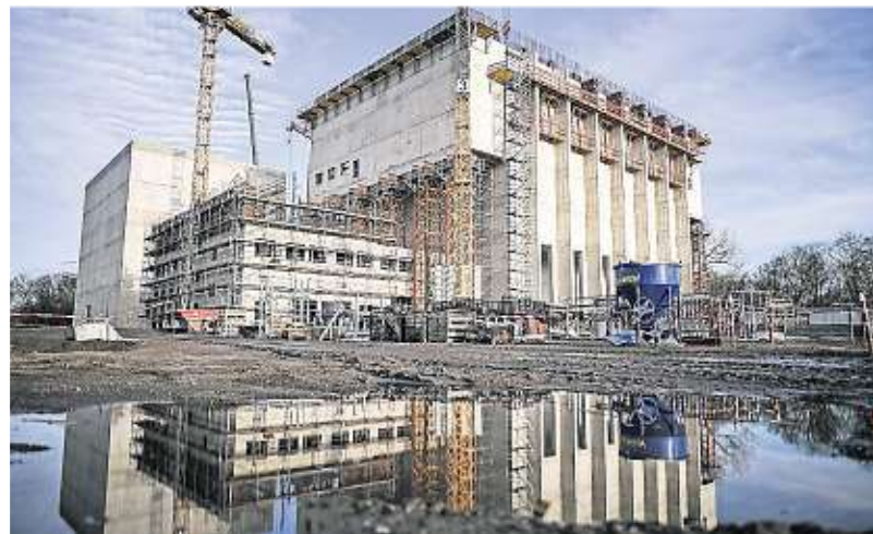
Auf der Baustelle des Dinslakener Holzenergiezentrums sind mehrere Kräne im Einsatz.
